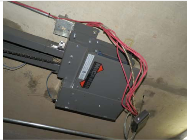
Micanan motor & door controls
